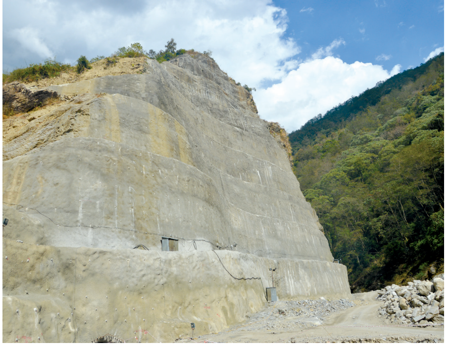
■ मेलम्ची आयोजना निर्माण कार्यको जटिलता भत्काउने 'ओपन कट' । मेलम्चीको पानी यही संरचनामार्फत् मेलम्ची सुरक्षमा प्रवाहित गरिनेछ ।
